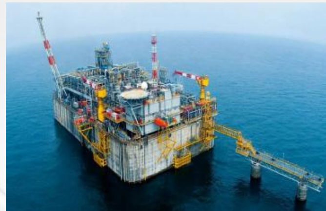
Off shore su piattaforma – Porto Viro (RO)
